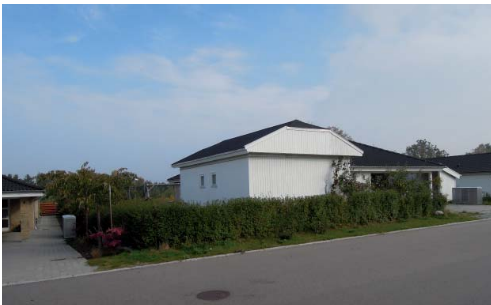
Set fra adgangsvej/ Signalet
